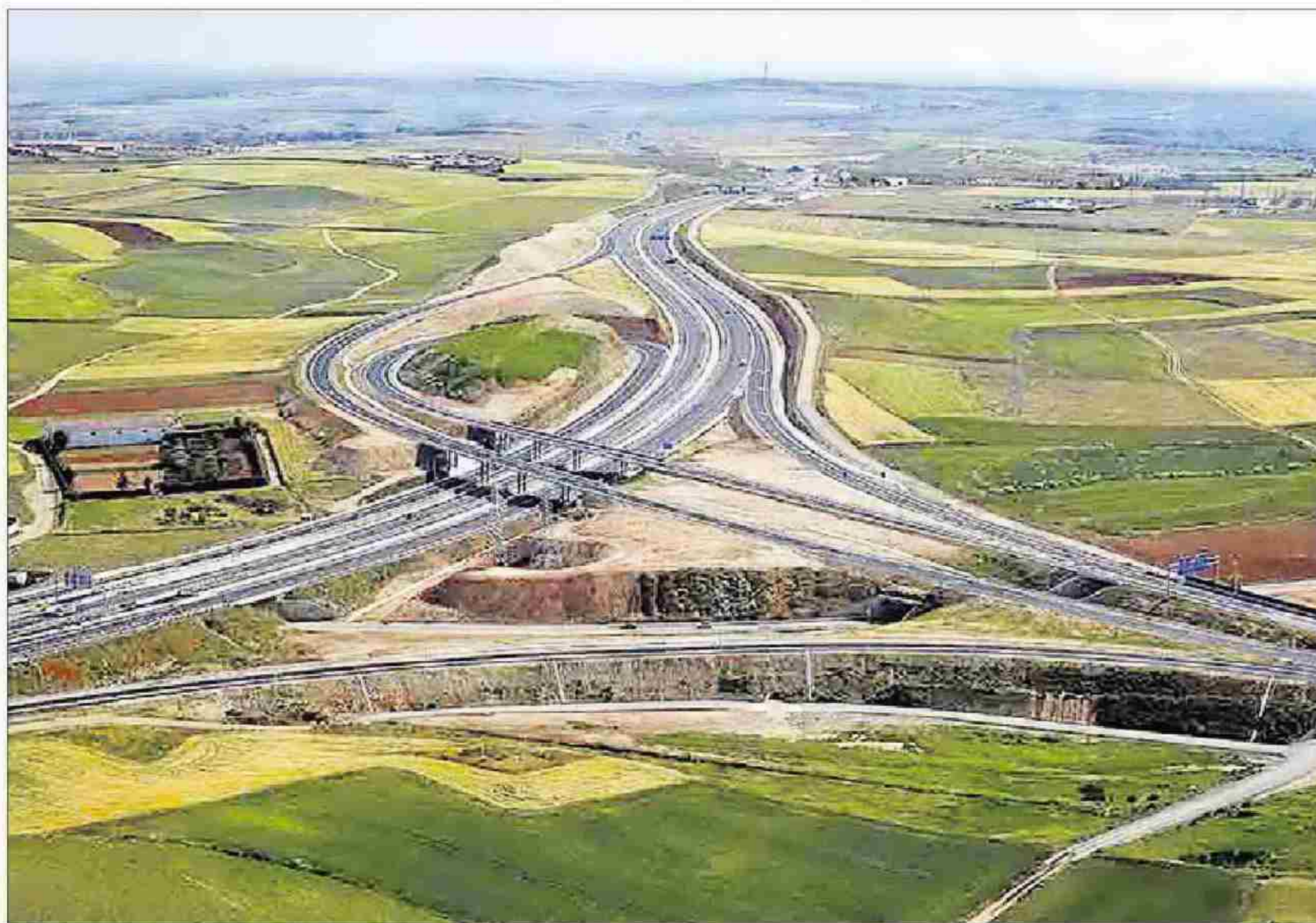
Una de las carreteras construidas por Sando. LA OPINIÓN
